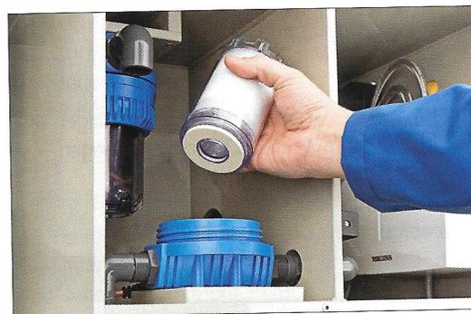
Abb. 3: Einsetzen DK-DOX® CAPS in Einspülvorrichtung.
